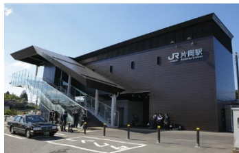
新しくなった片岡駅舎
